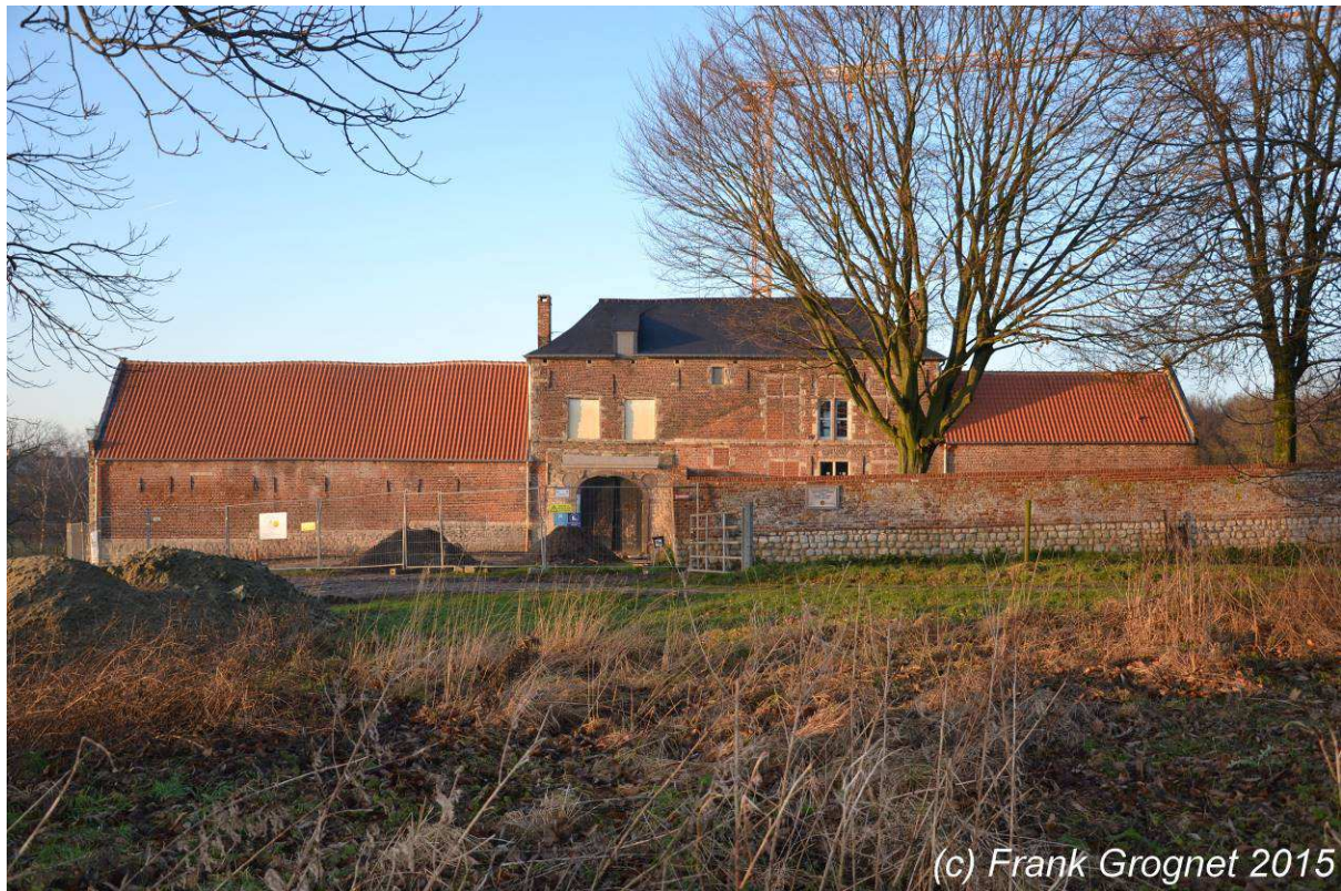
Figure 1 - Germe d'Hougoumont (travaux de restauration pour le bicentenaire 2015)
